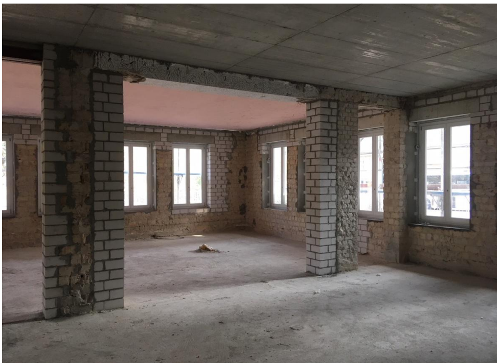
Aufmauerung Stützen
