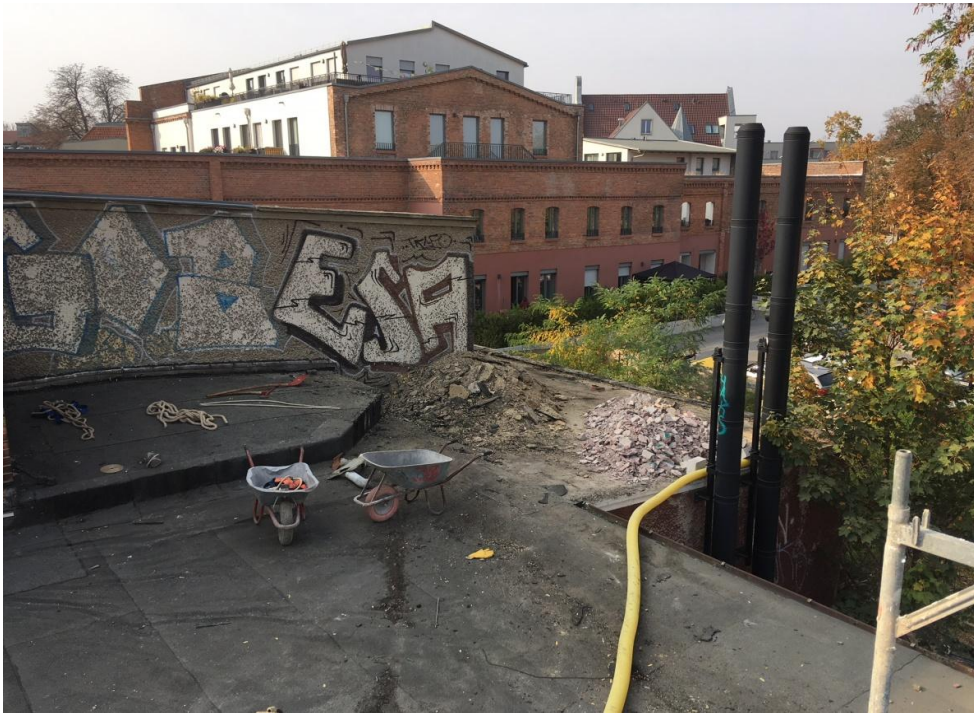
Abriss Dachhaut - Vorbereitung Abriss Saalanbauten
