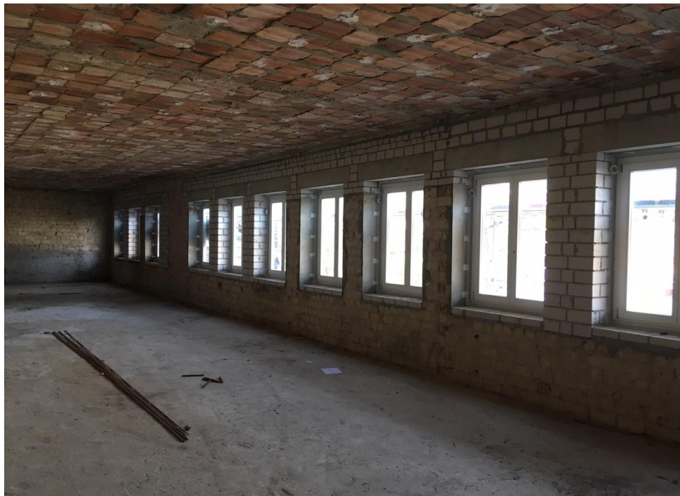
Einbau Holzfenster Anbau
