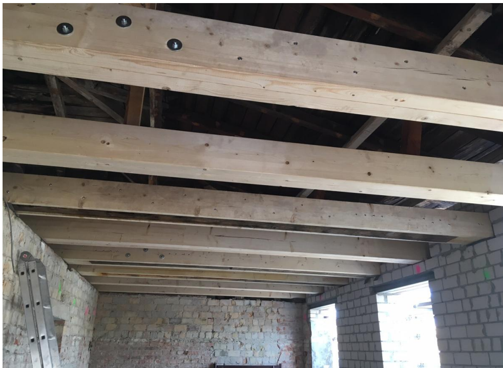
Herstellung neuer Holzbalkendecke und Ausführungsbeginn Sanierung Dachstuhl - Villa / Altbau
