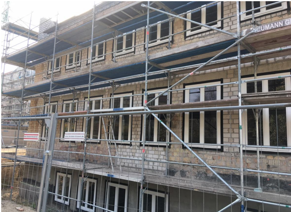
Einbau Holzfenster Anbau
