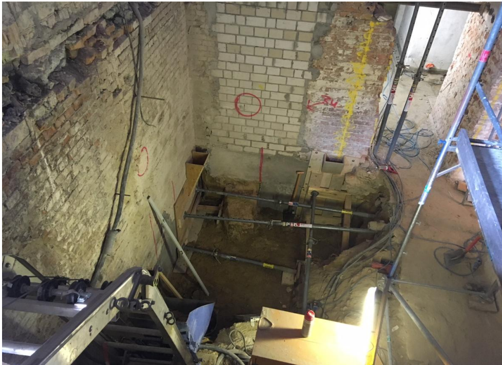
Herstellen der Aufzugsunterfahrt
