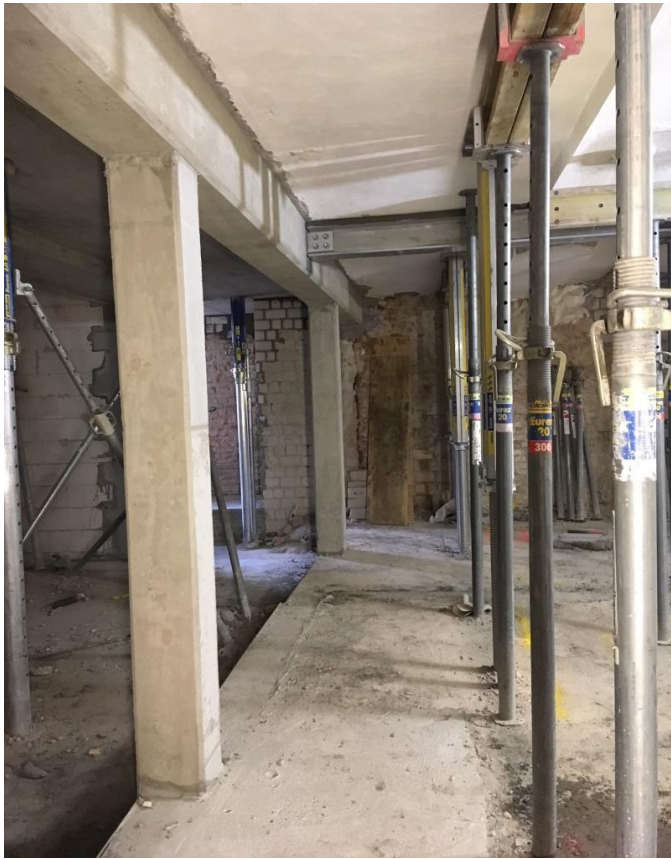
Herstellen neuer Stützen / Unterzüge
