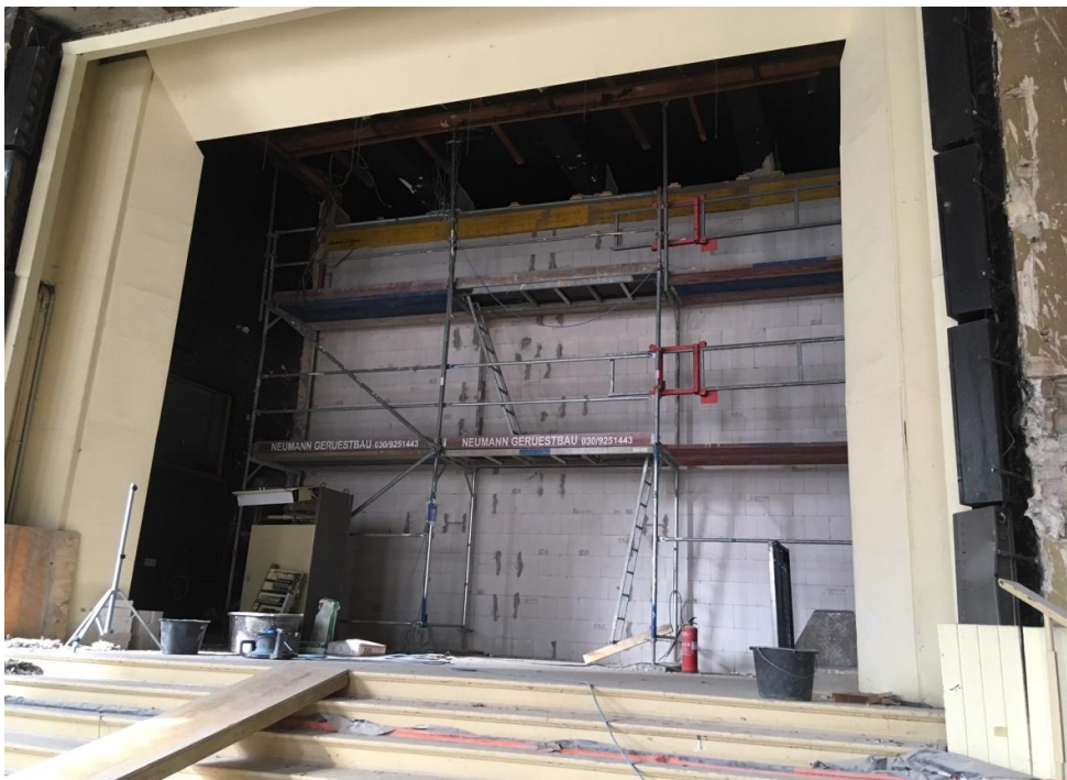
Aufmauerung Saalwand
