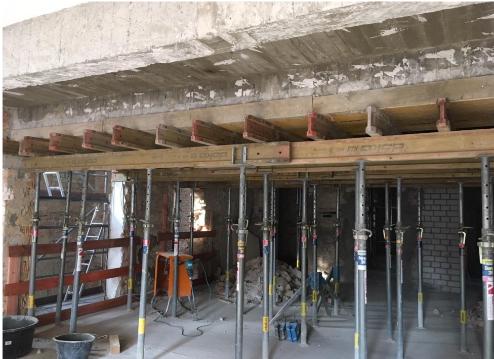
Herstellung neuer Decken - hier Altbau / Villa Decke über 1. OG
