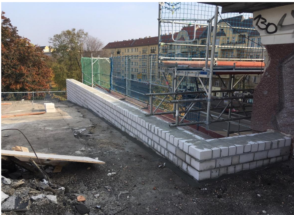
Herstellen neuer Attika
