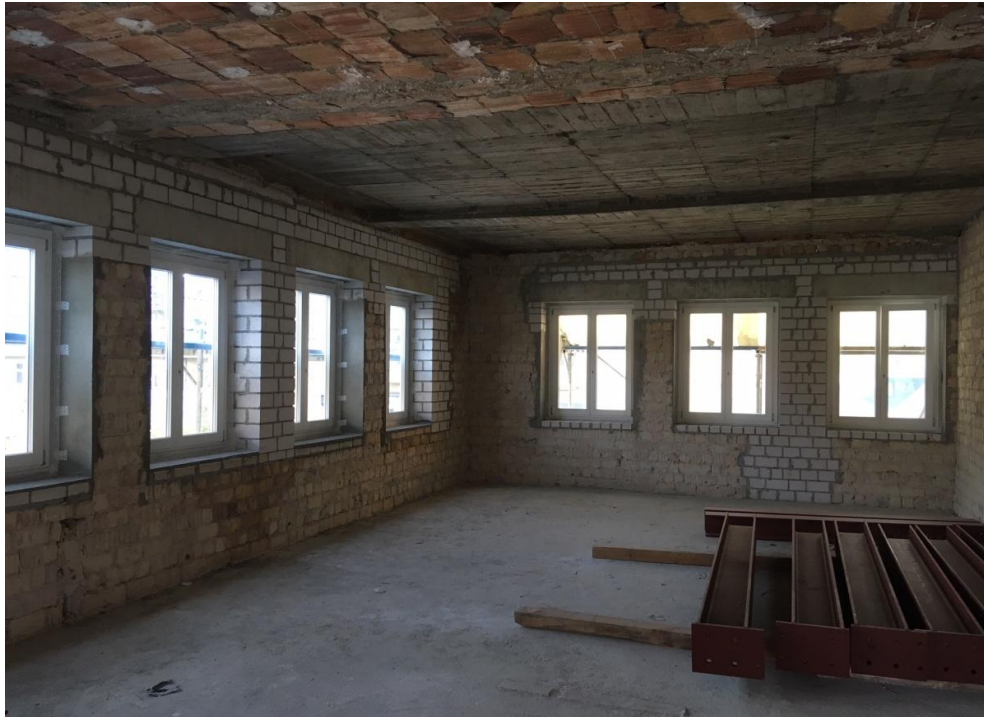
Einbau Holzfenster Anbau
