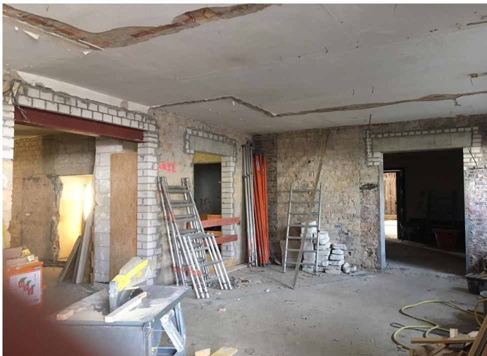
Herstellen neuer Türdurchbrüche / Tüerstürze
